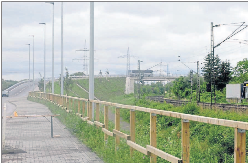
Schon vor der offiziellen Eröffnung befuhren erste Fahrzeuge die neue Brücke.
