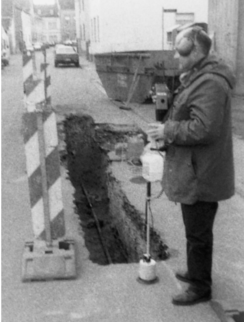
In der Mainzer Straße, direkt am Bahnhof, führten Mitarbeiter der Gemeindewerke in der vergangenen Woche an einem freigelegten Kabel Messungen durch.
