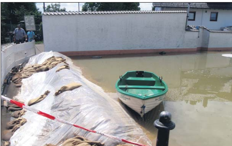
Künstlich aufgeschütteter Damm am Rhein Kiosk.
